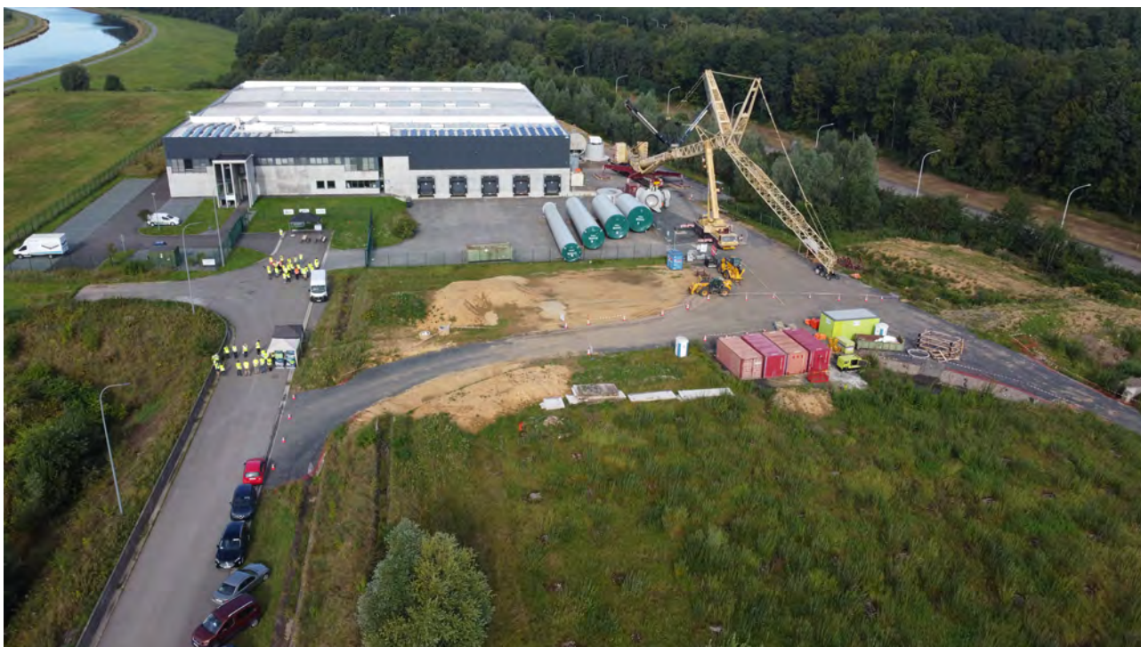
Vue aérienne du chantier de l'éolienne de La Louvière lors de la visite des coopérateurs, le 15 août 2023
