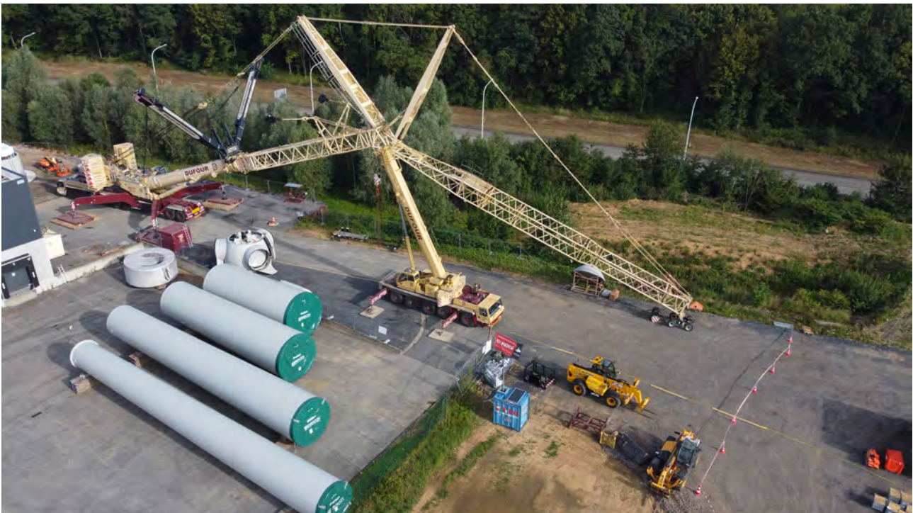
Le rotor et les éléments du mât de l'éolienne de La Louvière au pied de la grue imposante pour leur assemblage
