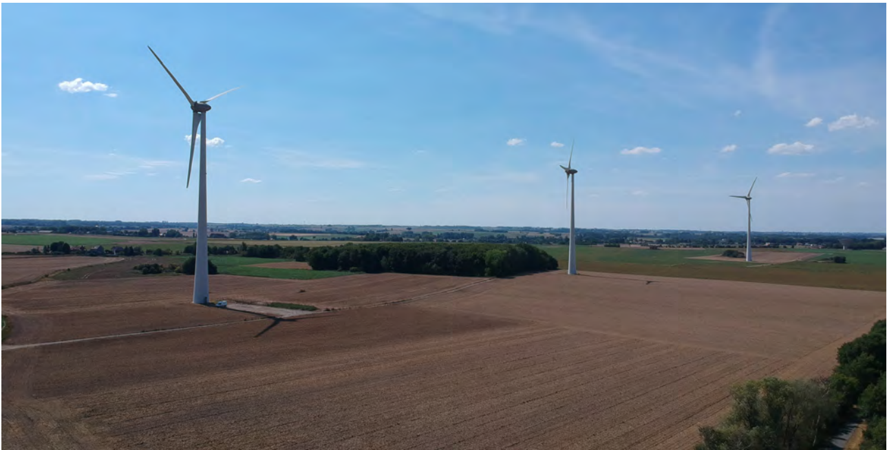
Les éoliennes MHP à Dour-Quévrain
