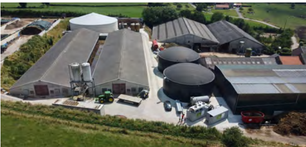
Vue aérienne des installations à Aubel
