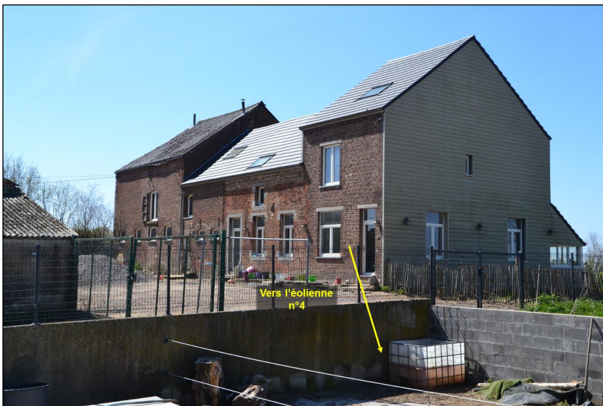
Figure 148 : Vue de la façade avant de l'habitation isolée sise rue du Cerisier n°12 (source : CSD, 2021).
