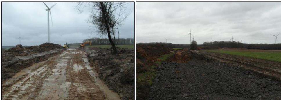
Figure 15 : Décapage du sol en vue de la création d'un nouveau chemin d'accès avec stockage des terres arables en merlons.
