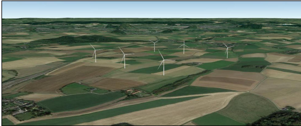
Figure 127 : Vue aérienne du projet depuis le sud (source : GoogleEarth, 2021 ; facteur d'exagération du relief : 2x).
