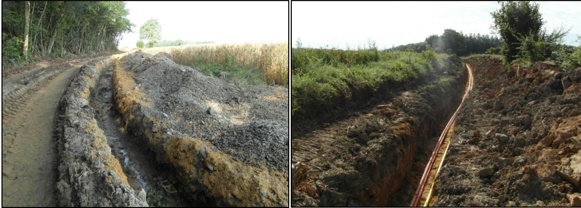
Figure 16 : Travaux de pose de câbles de raccordement.
