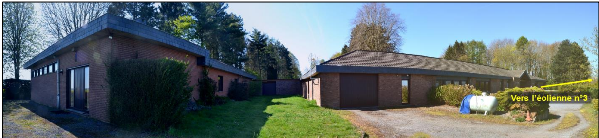
Figure 134 : Vue de la façade avant de l'habitation isolée sise rue de Névergies n°2 (source : CSD, 2021).
