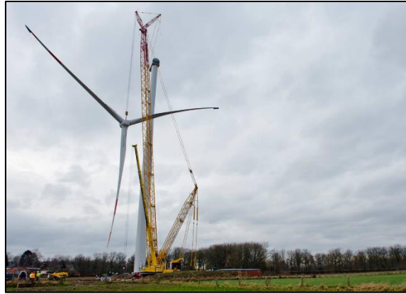
Figure 19 : Différentes étapes du montage d'une éolienne (source : Storm, parcs éoliens de Westerlo (2014), Wachtebeke (2012) et Maasmechelen (2014)).
