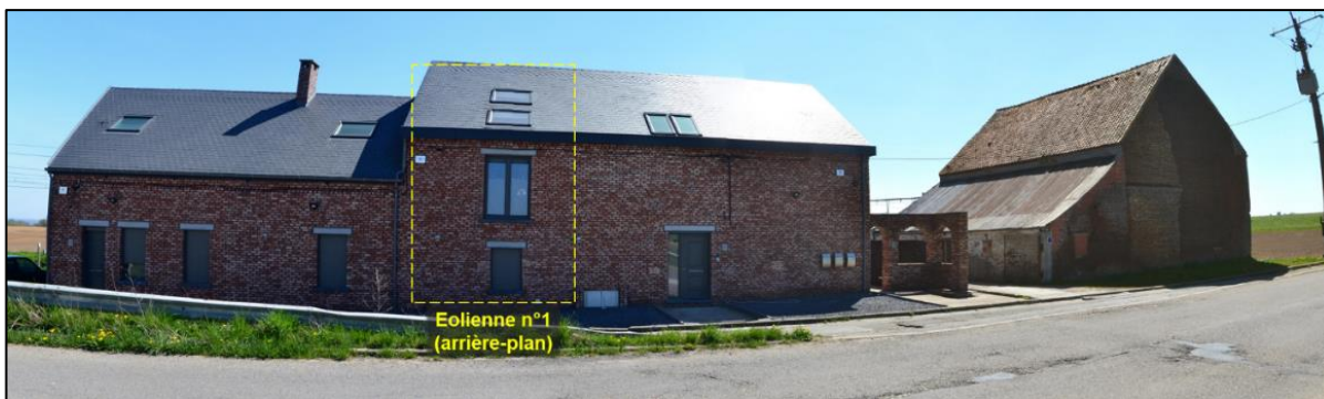
Figure 131 : Vue de la façade avant des habitations sises rue du Cerisier n°13 et 13/1 (Source : CSD, 2021).
