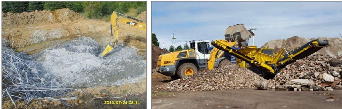
Figure 25 : Démantèlement de la fondation d'une éolienne – séparation des fers et concassage du béton (Schmees Bau GmbH, 2013).
