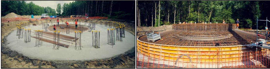
Figure 18 : Différents stades d'exécution d'une fondation circulaire (source : Storm, parc éolien de Gand, 2016).
