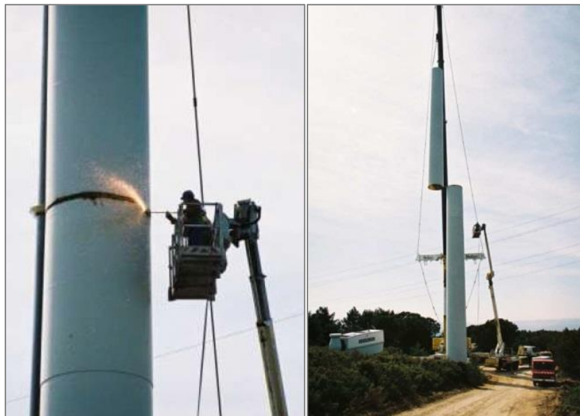
Figure 27 : Découpage et démontage d'une éolienne (Sallèles-Limousis (France), 2010).
