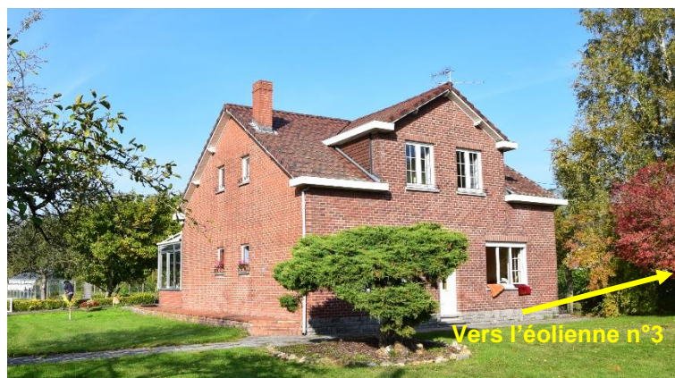
Vue façade ouest de l'habitation n°49 (source : CSD, 2019).
