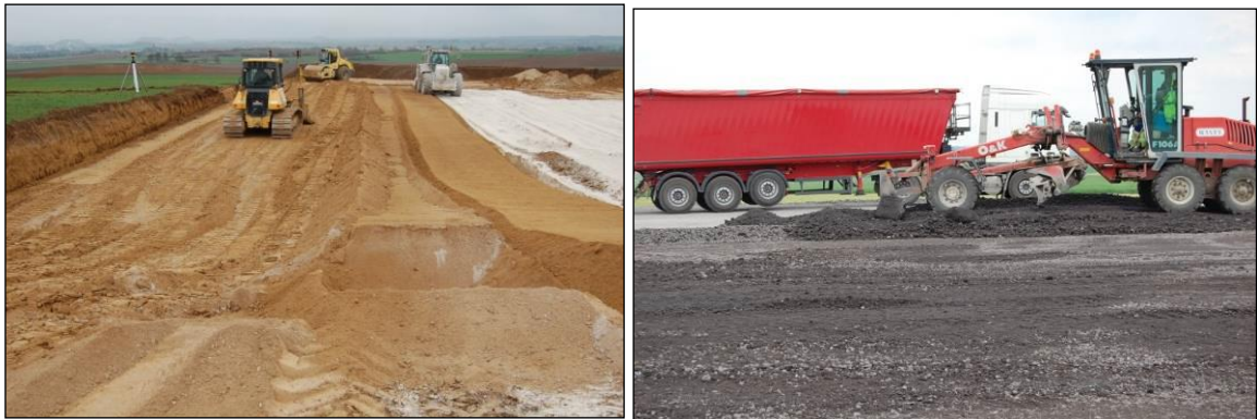
Figure 17 : Aire de montage au pied d'une éolienne (source : WindVision).
