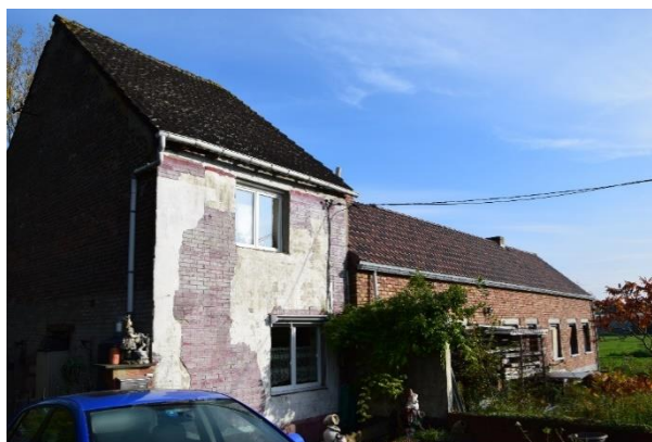
Vue façade avant des habitations n°182-180 (source : CSD, 2019).
