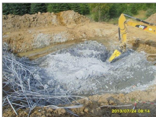
Figure 25 : Démantèlement de la fondation d'une éolienne – séparation des fers et concassage du béton (Schmees Bau GmbH, 2013).
