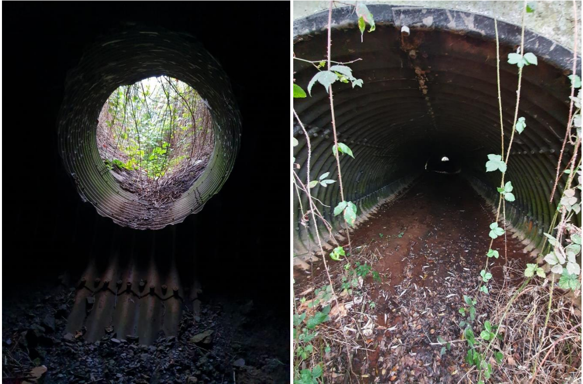
Figure 37: Pertuis à proximité de l'autoroute permettant la continuité du ruissellement.
