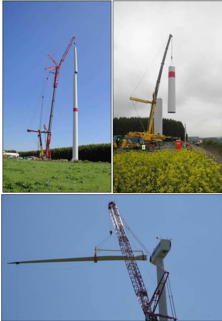
Figure 19: Différentes étapes du montage d'une éolienne (source : WindVision).
