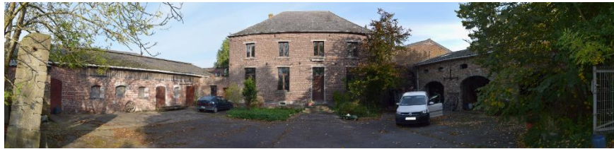
Vue façade avant (façade au sud) de l'habitation n°188 (source : CSD, 2019).
