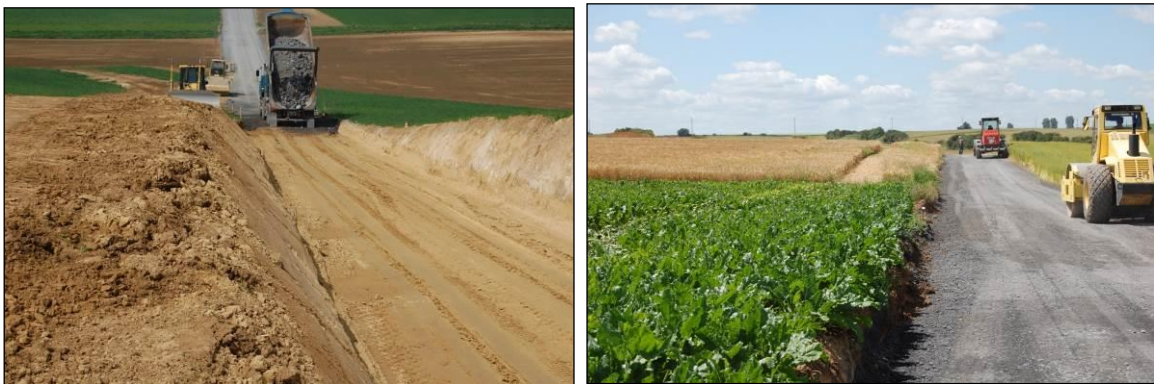
Figure 15 : Aménagement d'un nouveau chemin d'accès (source : WindVision)
