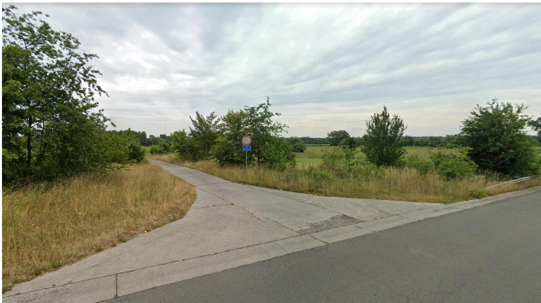
Figure 3: Rue des Herbières, portion située au nord du projet et qui n'est accessible qu'au convoi agricole et qui longe l'autoroute.
