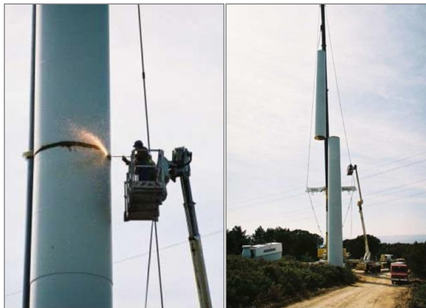
Figure 27 : Découpage et démontage d'une éolienne (Sallèles-Limousis (France), 2010).
