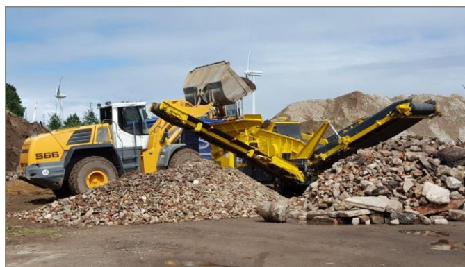
Figure 25 : Démantèlement de la fondation d'une éolienne – séparation des fers et concassage du béton (Schmees Bau GmbH, 2013).
