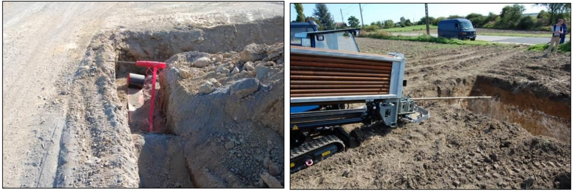
Figure 16 : Ouverture d'une tranchée pour le raccordement électrique interne et forage dirigé (source : WindVision)
