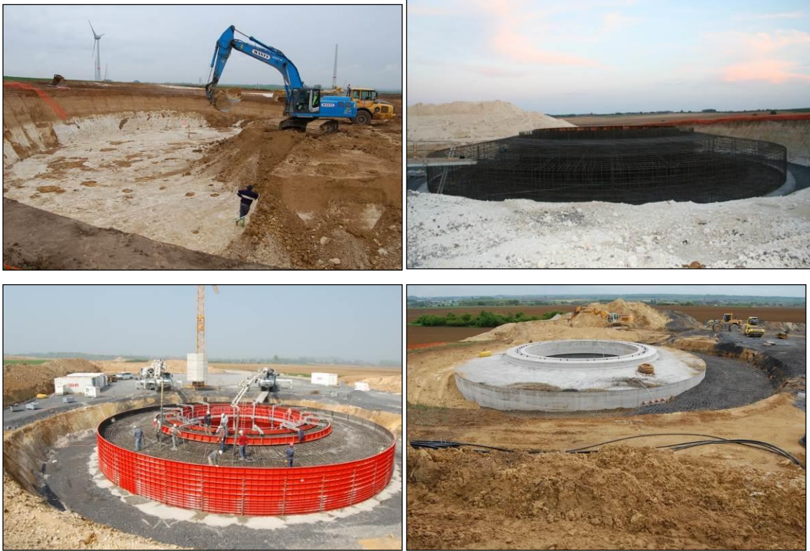
Figure 18 : Différents stades d'exécution d'une fondation cruciforme (source : WindVision).
