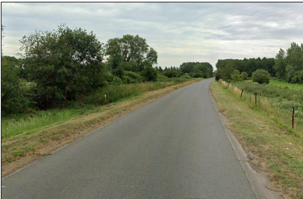
Figure 81 : Rue des Sarts et accotements herbeux où est prévu le raccordement électrique externe.
