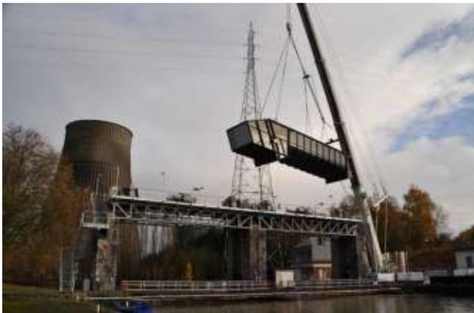
Vous pouvez apprécier sur les photos qui illustrent ce document que cette phase de construction a connu quelques étapes spectaculaires comme la livraison et l'installation des "cages à vis" ou les essais de levage de l'installation (plus de 200 Tonnes en 20 minutes).
