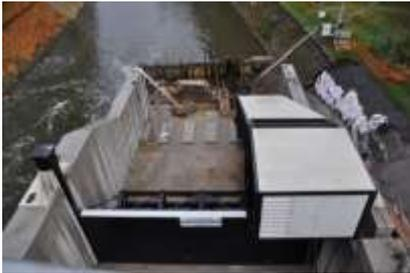
Pour que les turbines soient alimentées en eau, il faut ouvrir complètement la vanne du barrage. L'eau est alors arrêtée par une vanne sur laquelle viennent se poser les têtes de vis et qui est réglée de manière à permettre le débordement de l'eau afin d'alimenter les vis et faire tourner celles-ci.
