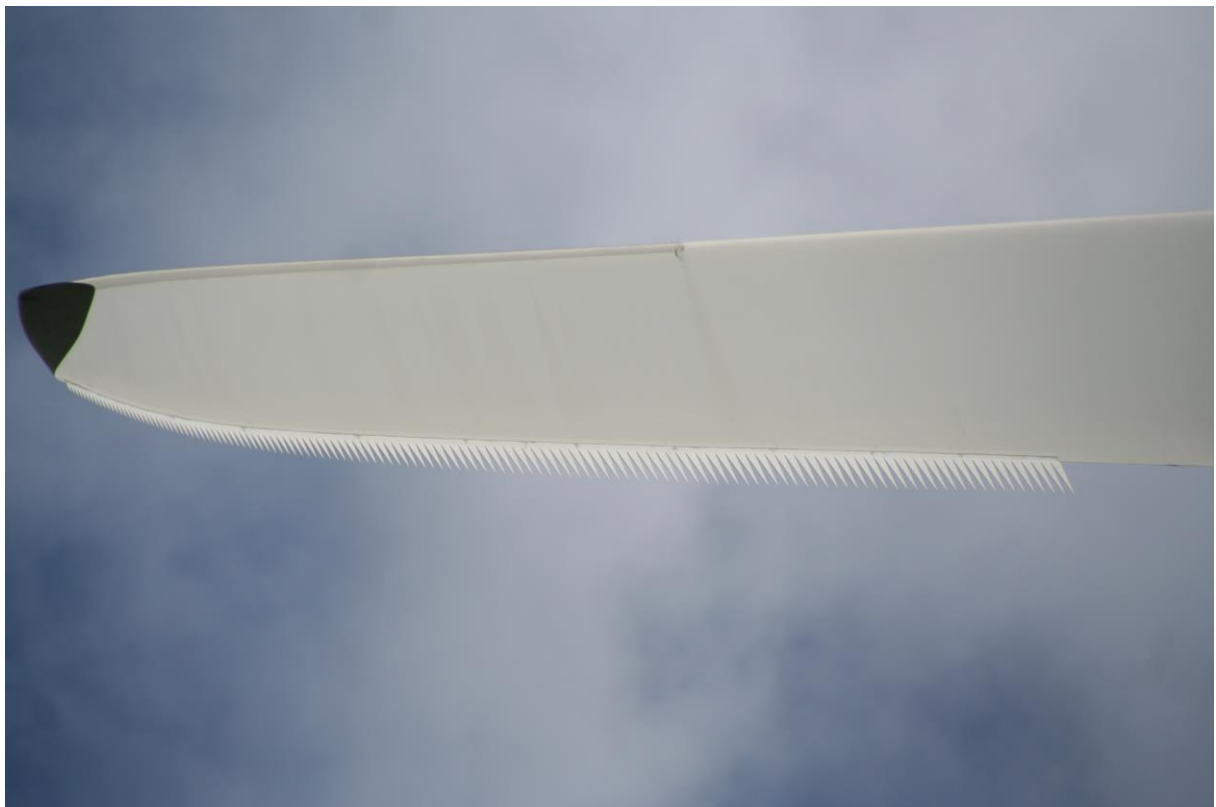
Le 26 avril 2018, des peignes sont installés en bout de pale sur l'une des deux éoliennes de MHP. Les peignes amortissent le bruit, à la manière des plumes de certains rapaces.
